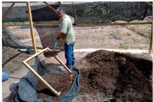
Foto 14. Tamizado para separar partículas superiores a 16mm.
